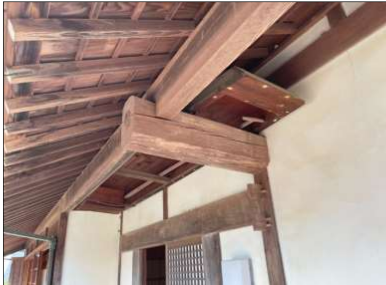
母屋に設置されている上げ船の写真
